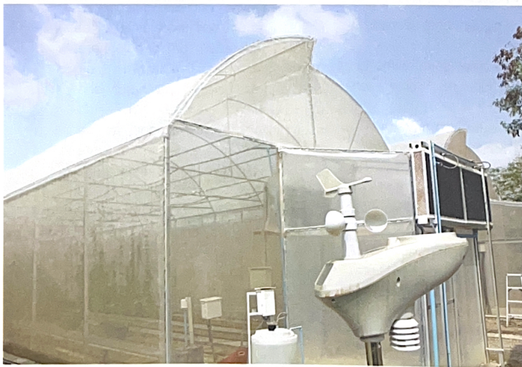
๐ โรงเรือนปลูกฮอปส์ ภายนอกมีการติดตั้งเครื่องวัดสภาพอากาศส่วนภายในมีการติดตั้งระบบเซนเซอร์ต่าง ๆ
