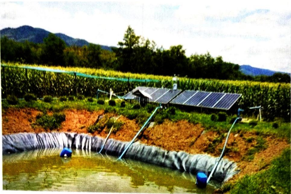
△ ภาพที่ 5 ระบบบีบีมัน้ำพัล้งงานแสงอาทิตย์สำหรับแปลงปลูกข้าวโพดหวานแบบอุตสาหกรรม
