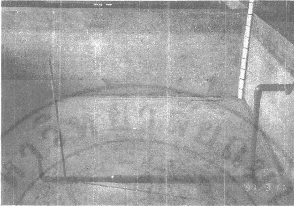
รูปที่ 9 : ท่อท่ฟองอากาศในแนวตั้ง ขณะติดตั้งเสร็จแล้ว
