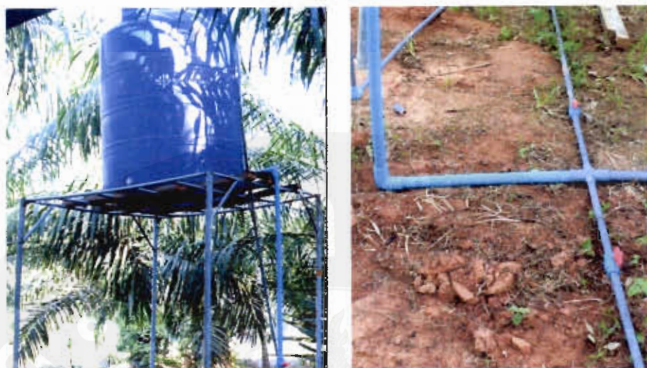
ภาพที่ 16 การติดตั้งถัง และระบบการให้น้ำต้นกล้วยบริเวณโคนกาบใบต้นปาล์มน้ำมัน
