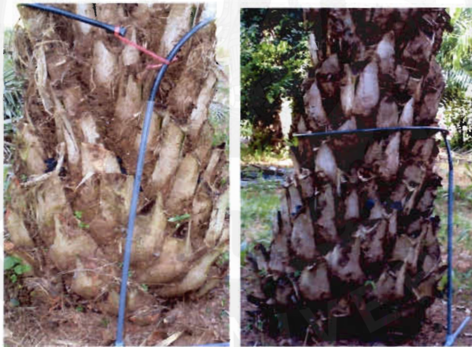
ภาพที่ 13 การติดตั้งระบบน้ำ และระบบน้ำหยด
