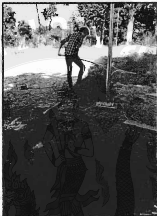
ภาพที่ 23 หลุมนำสายไฟฟ้าจากเสาไฟเข้าสู่ระบบผลิตกระแสไฟฟ้าพลังงานแสงอาทิตย์
