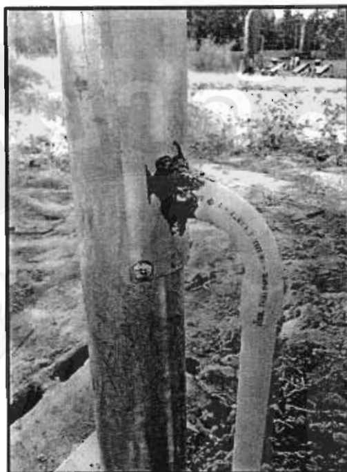
ภาพที่ 25 รูเสาไฟสำหรับต่อสายไฟ
