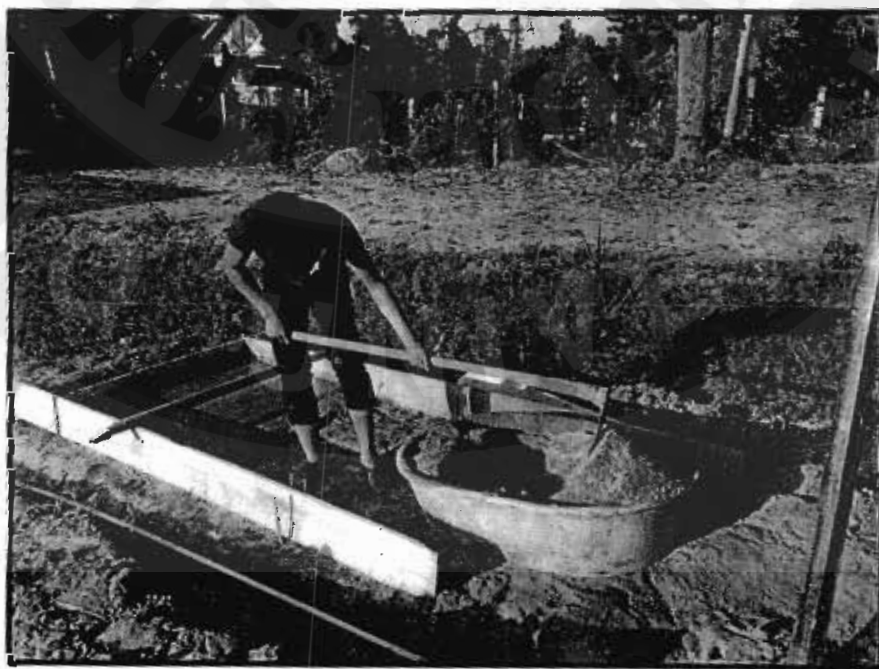
ภาพที่ 24 ฐานวางและยึดระบบผลิตกระแสไฟฟ้าพลังงานแสงอาทิตย์
