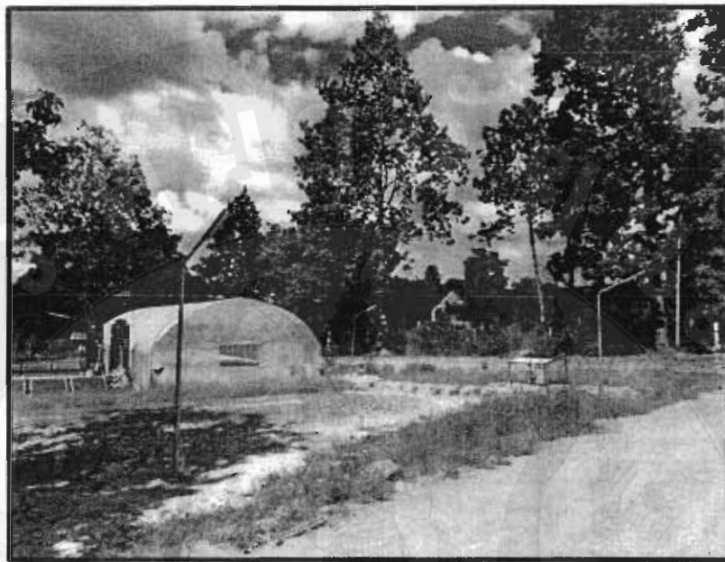
ภาพที่ 27 ระบบผลิตกระแสไฟฟ้าพลังงานแสงอาทิตย์และเสาไฟถนน
