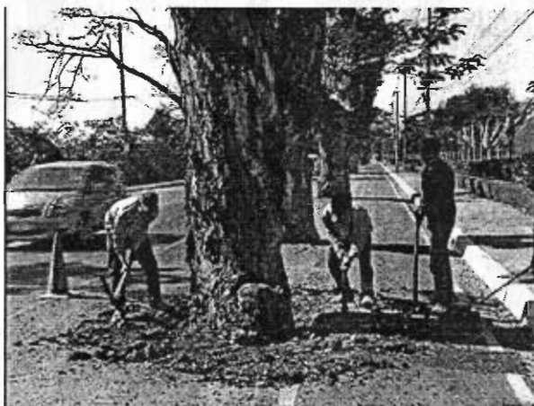
ภาพที่ 5.5 การเปิดผิวทางแอสฟัลต์รอบโคนต้นไม้เพื่อให้อากาศและเติมน้ำ ธาตุอาหาร ลงไปในดิน
