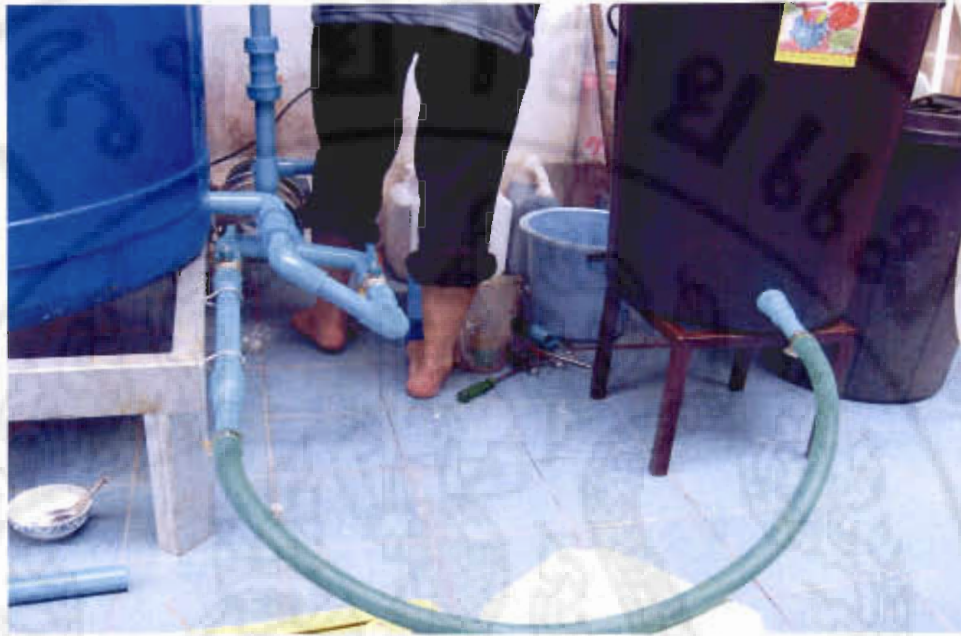
ภาพภาคผนวกที่ 5 การต่อท่อจากช่องทางรับของเหลวภายนอกกับถังผสม
