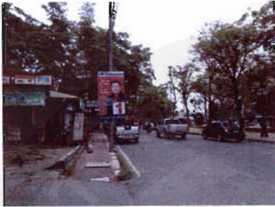
ภาพที่ 40 ทอระบายน้ำ
