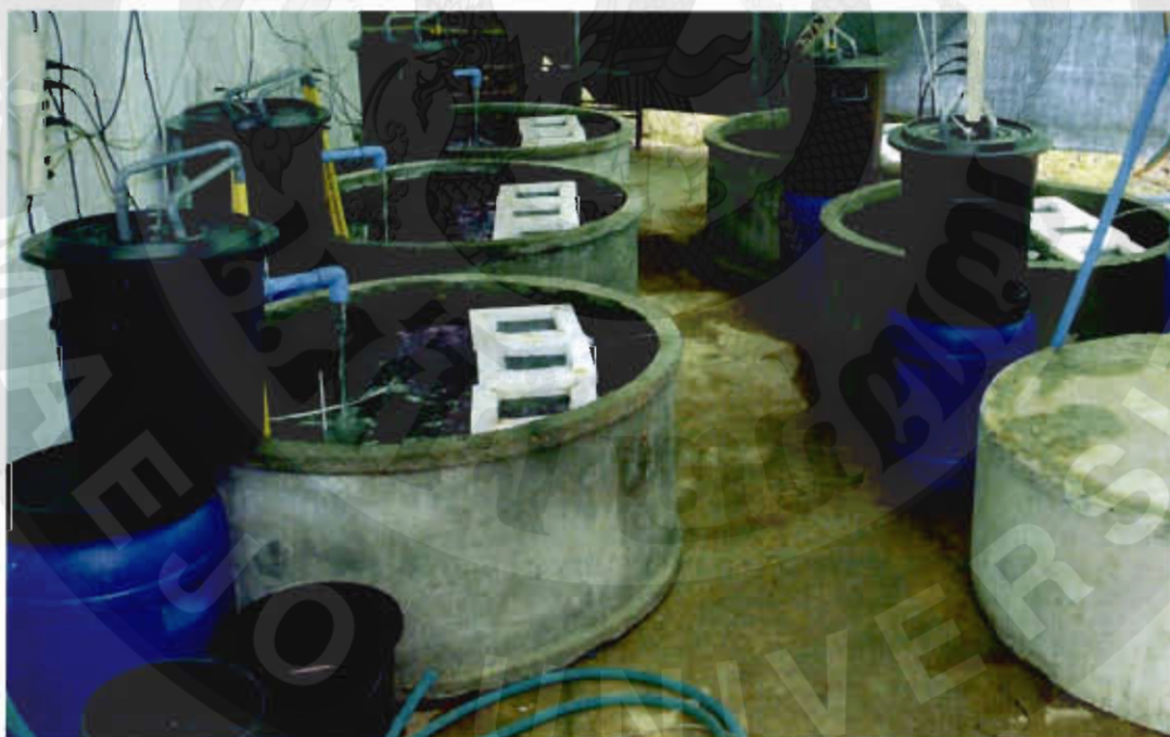
ภาพที่ 15 ป่อซีเมนต์กลม ขนาดเส้นผ่านศูนย์กลาง 100 เซนติเมตร พร้อมทั้งติดตั้งระบบบำบัดน้ำ
