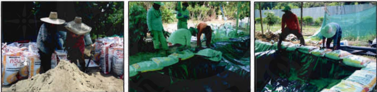
(ง) ทำการบรรจุทรายในกระสอบปุย และนำไปจัดวางรอบขอบบ่อทดลอง
