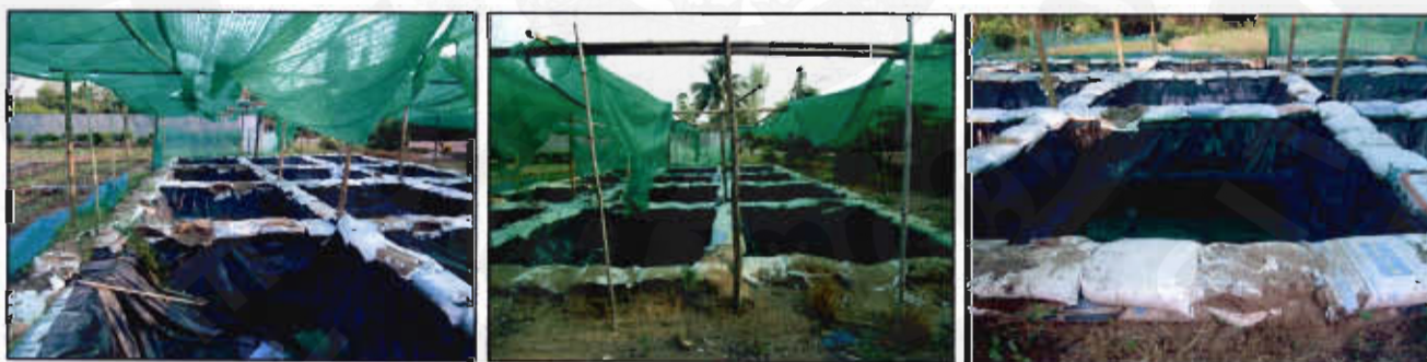
(ก) สภาพบ่อทดลองก่อนทำการปรับปรุงซ่อมแซม
