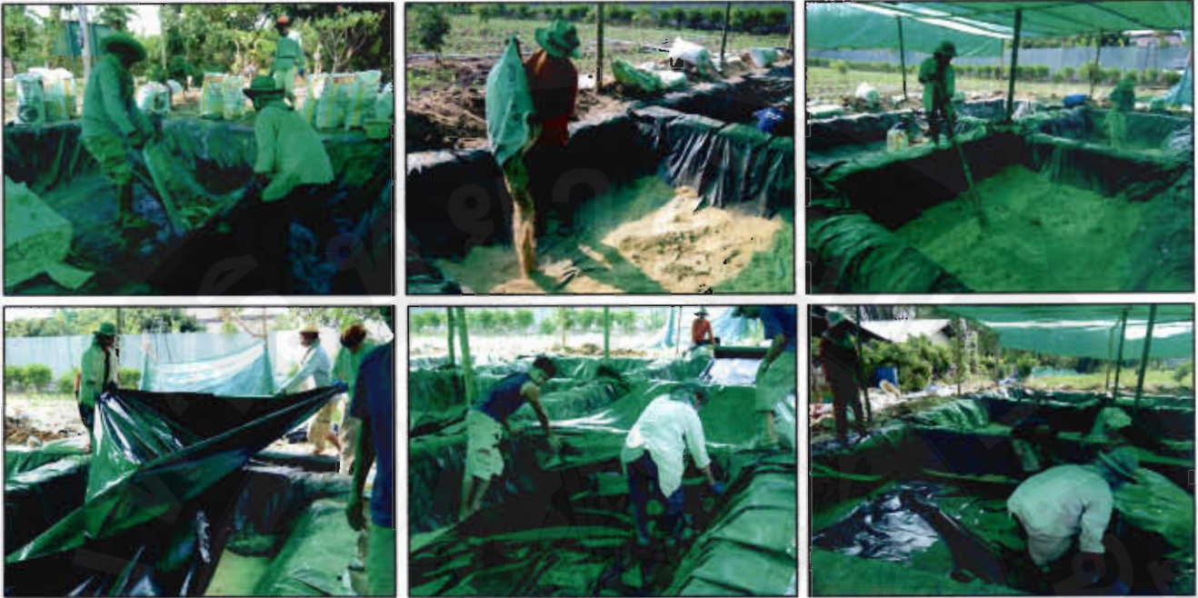
(ค) ทำการปรับปรุงซ่อมแซมพื้นบ่อ รองพื้นบ่อด้วยแกลบและทำการปูพลาสติกสีดำที่พื้นบ่อทดลอง
