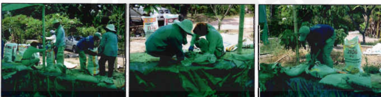
(ข) ทำการรื้อย้ายกระสอบทรายที่ชำรุดเสียหายรอบบริเวณบ่อทดลอง
