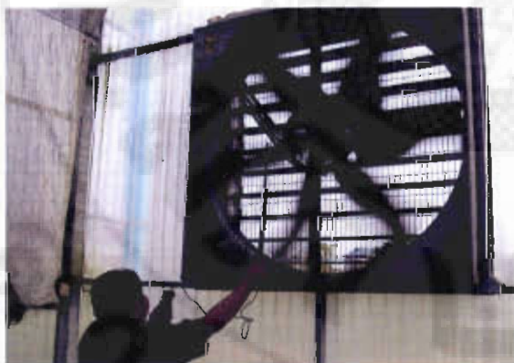
การวัดความเร็วลมที่พัดลมดูดอากาศ
