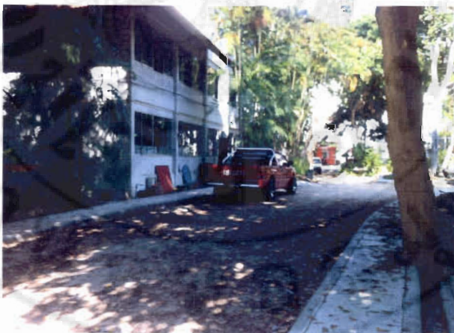
ภาพที่ 72 แสดงสภาพพื้นคอนกรีตในร่ม บริเวณทางเข้าตึกภูมิทัศน์ คณะสถาปัตยกรรมฯ ณ มหาวิทยาลัยแม่โจ้ เชียงใหม่
