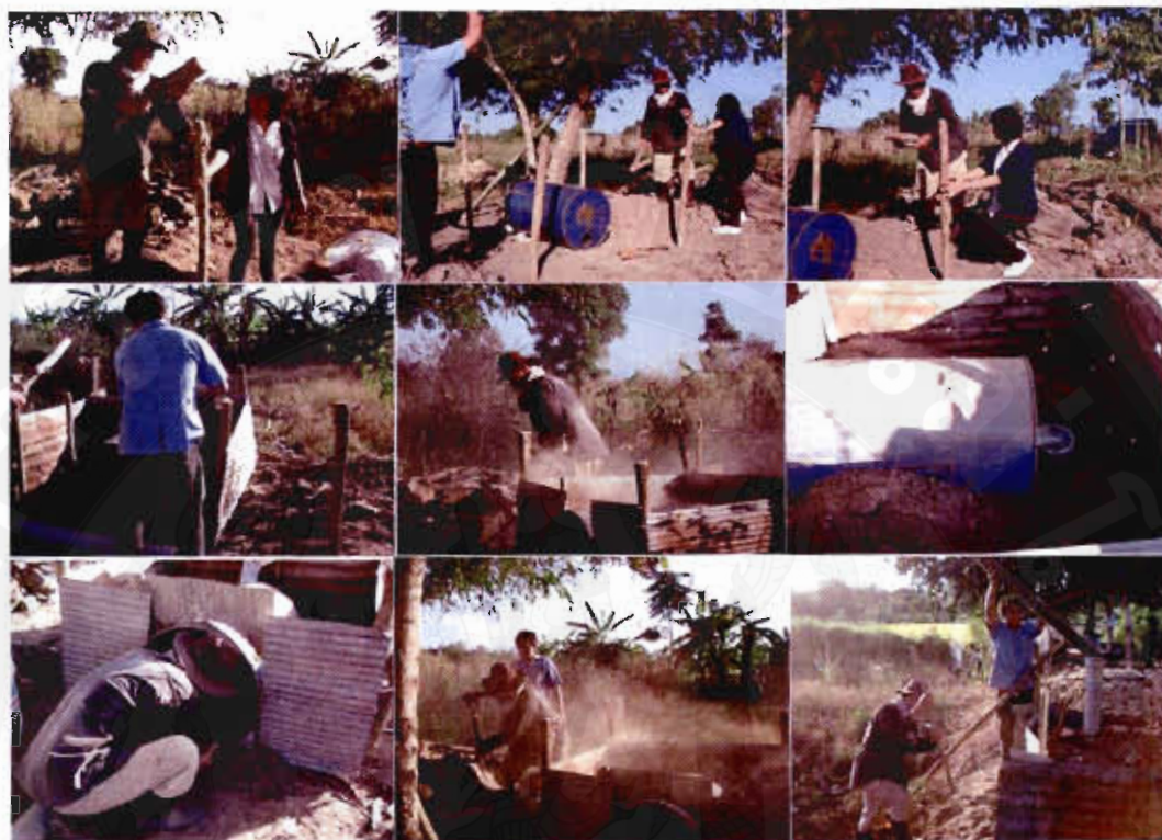
ภาพที่ 4.17 ลงพื้นที่ให้คำแนะนำและช่วยสร้างเตาเผาถ่าน 200 ลิตร ที่สวนของคุณเชิด อุทรอินทร์
