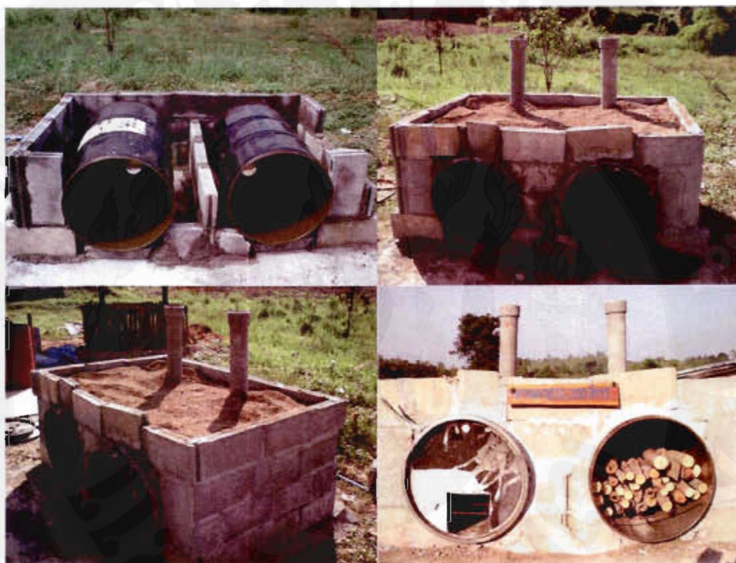
ภาพที่ 3.3 การสร้างเตาเผาถ่านไร้ควันชนิดอบเร่งสำหรับกลั่นน้ำส้มควันไม้แบบอยู่กับที่
