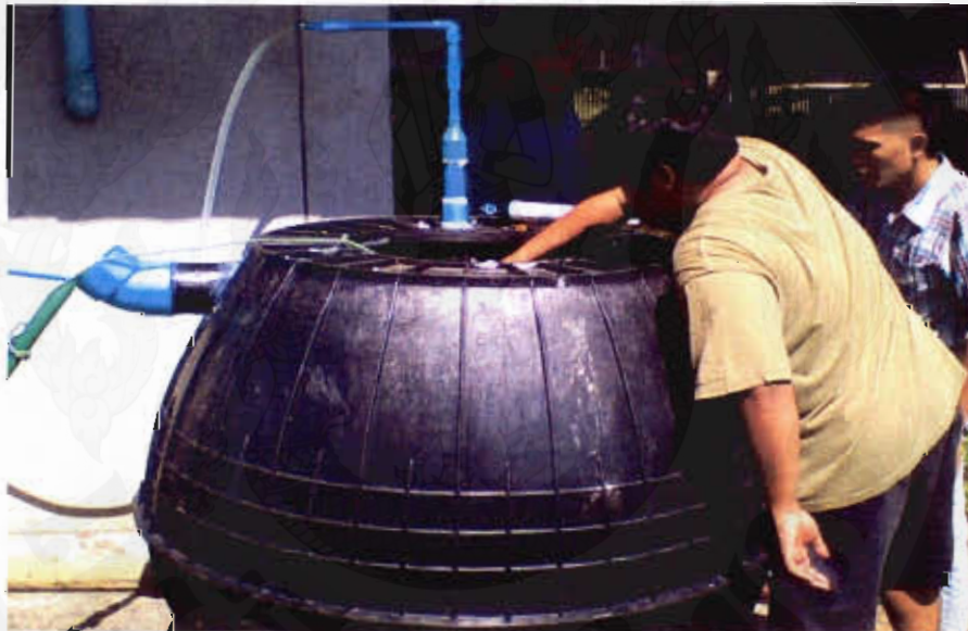
ภาพที่ 10 ถังหมักไร้อากาศ
