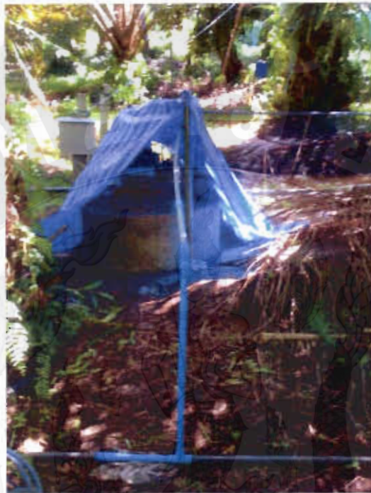
ภาพผนวกที่11 ลักษณะทั่วไปของเครื่องปั๊มลมและเครื่องสูบน้ำที่ใช้ในระบบน้ำหยดพร้อมทำงาน
