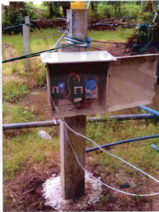
ภาพผนวกที่9 ตู้ควบคุมเครื่องปั๊มลมและเครื่องปล่อยน้ำหยด
