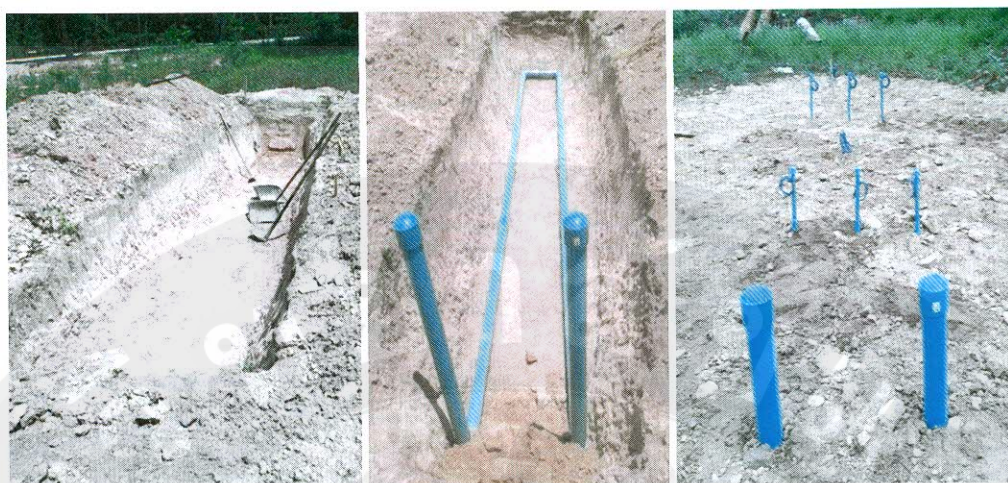
(ข) ท่อได้ดินแบบตัวยู และการติดตั้งพรบวัดอุณหภูมิดิน
