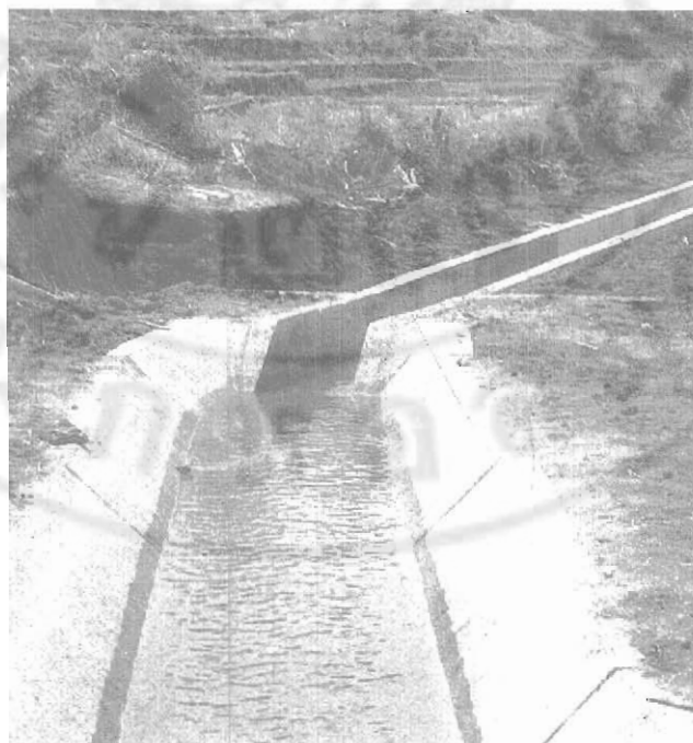
ภาพ 17 การทำคันดินกั้นน้ำและร่องน้ำเพื่อรองรับน้ำที่ไหลบ่ามาจากพื้นที่ที่สูงกว่าแล้วระบายออกสู่แหล่งน้ำธรรมชาติ
