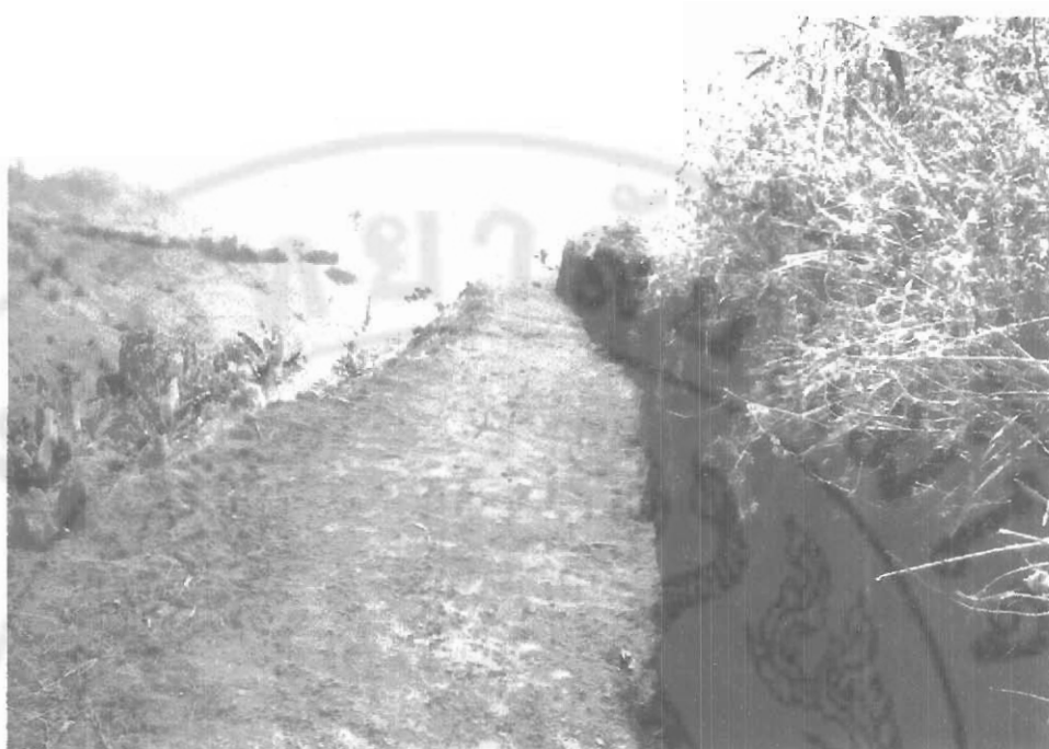
ภาพ 16 การทำคูรับน้ำขอบเขาเพื่อแบ่งความยาวของความลาดชันให้สั้นลงและรองรับน้ำให้ไหลลงสู่แหล่งน้ำธรรมชาติ
