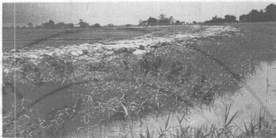
ภาพที่ 11 การทำคันดินโดยรอบพื้นที่โครงการจัดสรรที่ดินในชุมชนแม่โจ้ (ถ่ายเมื่อวันที่ 30 เมษายน 2532)
