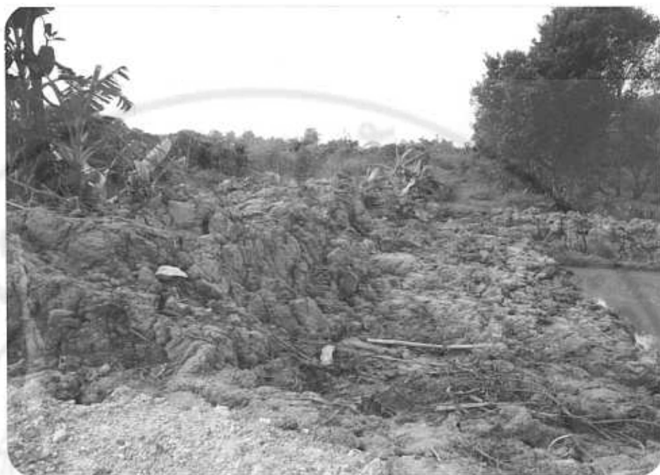
ภาพที่ 18 การเสริมคันดินให้สูงขึ้นเพื่อป้องกันน้ำท่วมบริเวณฟาร์มเพาะเลี้ยงลูกปลา ในชุมชนแม่โจ้ ถ่ายเมื่อวันที่ 3 พฤษภาคม 2532
