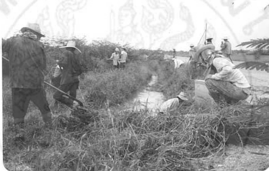
ภาพที่ 17 ชาวบ้านช่วยกันขุดลอกลำเหมืองระบายน้ำด้านทิศใต้ของหมู่บ้านทุ่งหมื่นน้อย
