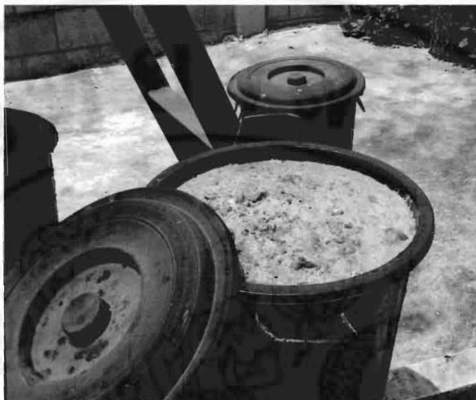
ภาพ 24 ไขมันที่แยกออกด้วยถังแยกของระบบแยกและย่อยไขมัน
