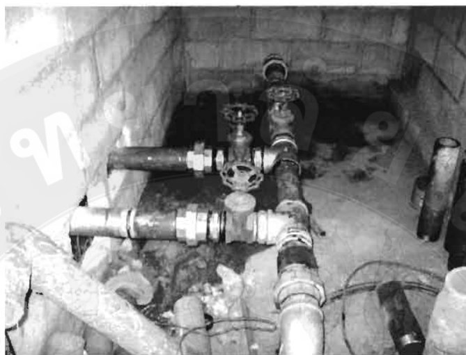
ภาพ 5 เครื่องสูบน้ำบาดาลหลังแก้ไขแล้ว
