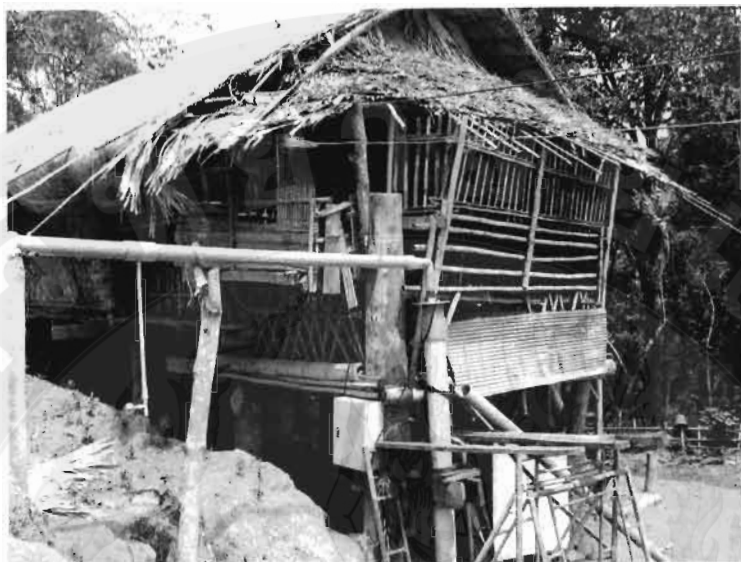
ภาพ 7 ติดตั้งเครื่องสูบน้ำที่บ่อปลสุตว์
