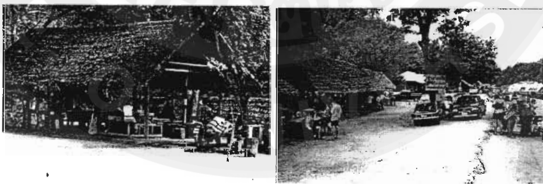
ภาพ 8 แสดงสถานที่ตั้งบริเวณทางเข้าของปางช้างแมวิน
