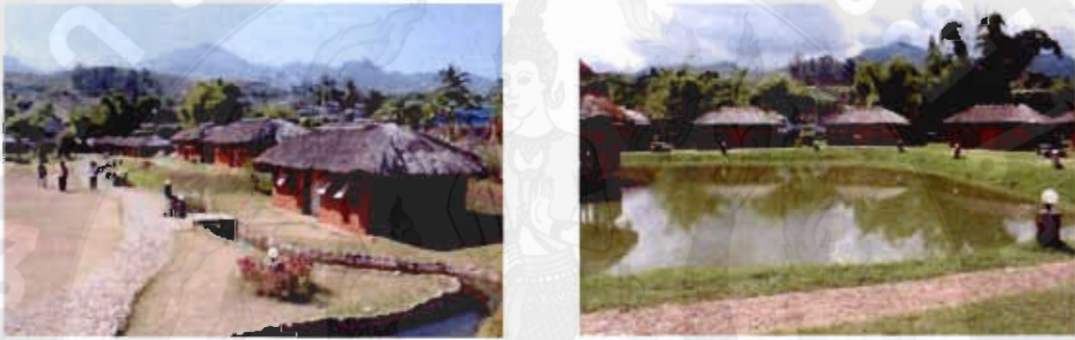
ภาพ 77 บ้านพักแบบแบบดินที่เปิดให้บริการเป็นบ้านพักในปี 2553
