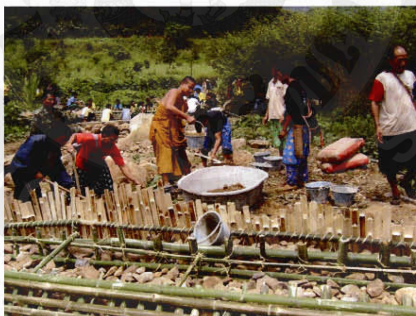
ภาพผนวก 17 การทำฝายชะลอน้ำชุมชนบ้านป่าคา ตามแผนการดำเนินงานโครงการพุทธอุทยาน
