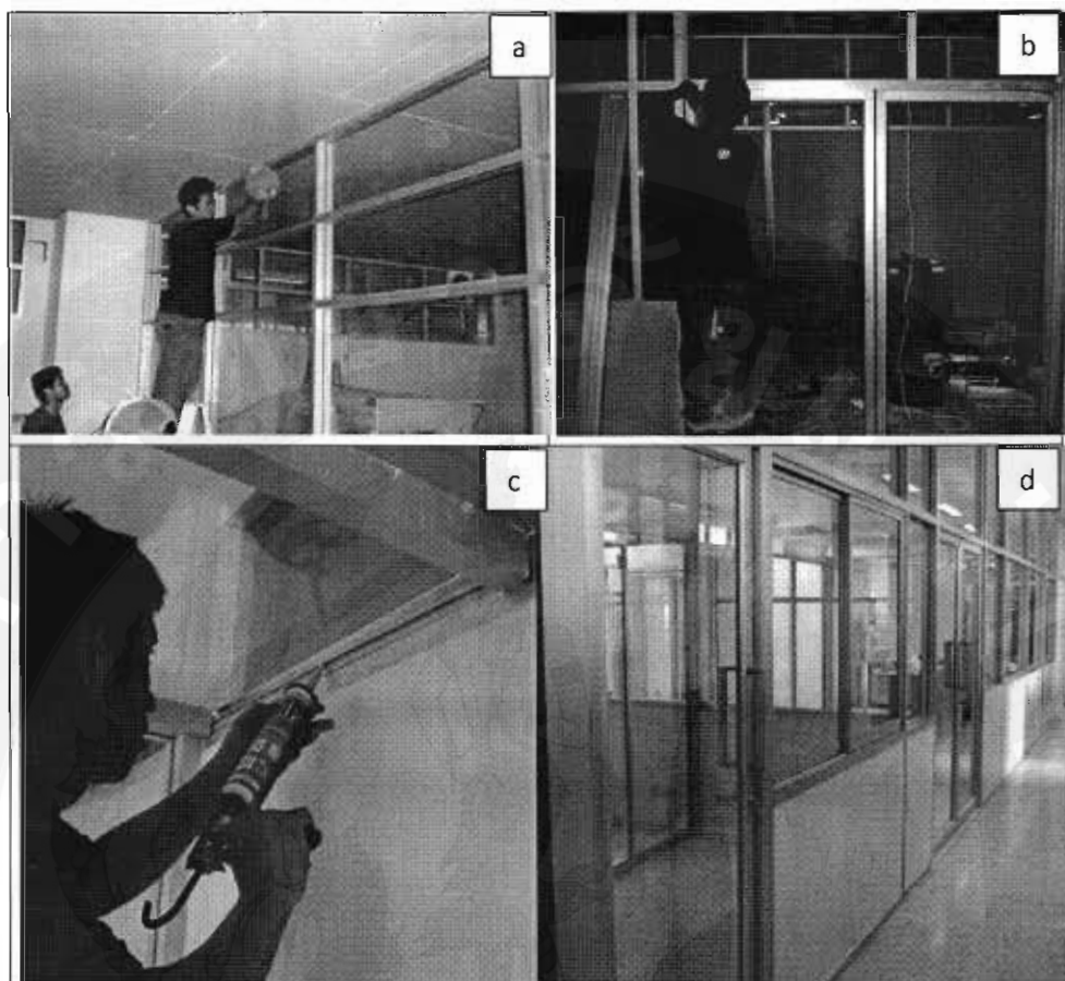
ภาพ 18 งานปรับปรุงและติดตั้งกระจก (a) การรื้อถอนกระจกเดิม (b) การติดตั้งโครงคร่าวสำหรับติดตั้งกระจก (c) การอุดช่องว่างระหว่างโครงอลูมิเนียมกับกระจก (d) งานกระจกหลังติดตั้งเรียบร้อยแล้ว
