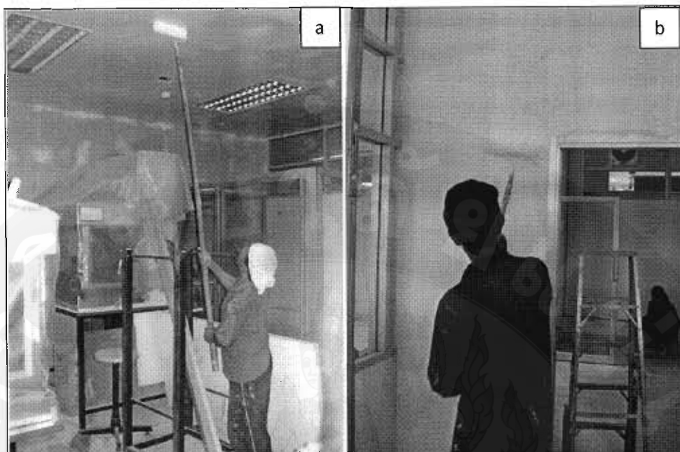
ภาพ 19 งานสี (a) การทาสีรองพื้นก่อนเริ่มการทาสีจริง (b) การทาสีห้องปฏิบัติการเพาะเลี้ยงเนื้อเยื่อคณะวิทยาศาสตร์
