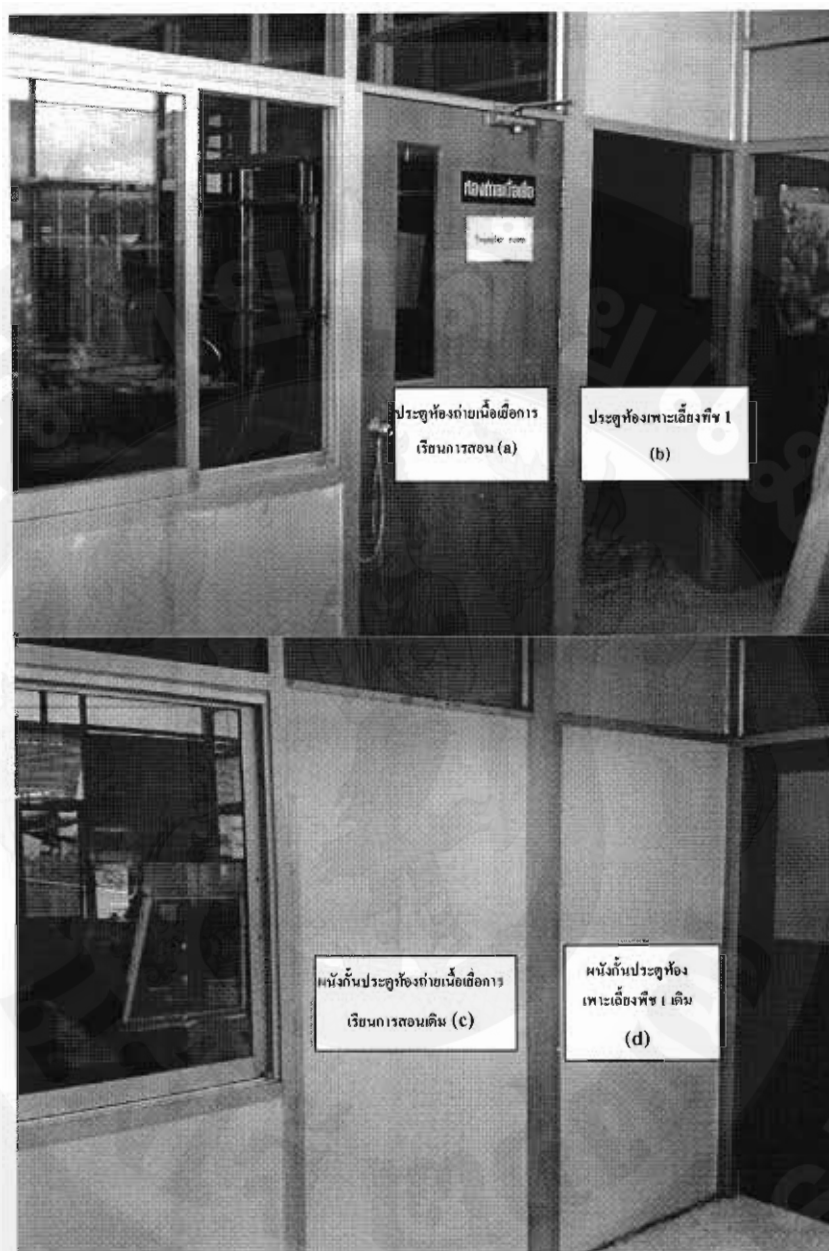
ภาพ 20 ตำแหน่งประตูเดิมก่อนและหลังการปรับปรุง (a) ประตูทางเข้าห้องถ่ายเนื้อเพื่อการเรียนการสอนเดิม (b) ประตูทางเข้าห้องเพาะเลี้ยงพืช 1 เดิม การปิดตำแหน่งประตู (c) การปิดประตูทางเข้าห้องถ่ายเนื้อเพื่อการเรียนการสอนเดิม (d) การปิดประตูทางเข้าห้องเพาะเลี้ยงพืช 1 เดิม
