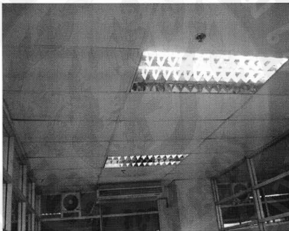
ภาพ 7 ลักษณะของฝ้าเพดานห้องปฏิบัติการเดิมเป็นแบบฝ้าที-บาร์
