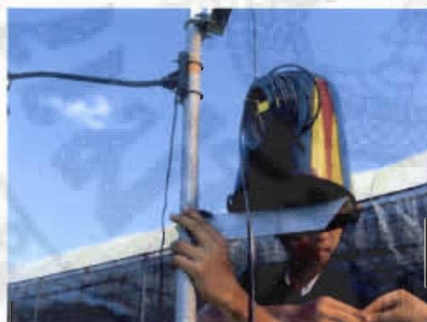
ภาพผนวก 8 การประกอบถังรับปริมาณน้ำฝน
