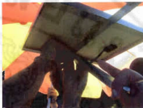
ภาพผนวก 9 การประกอบแผง solar cell ใต้ถังรับปริมาณน้ำฝนกับเสา
