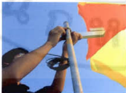
ภาพผนวก 6 การประกอบเซ็นเซอร์แสงกับเสาและปรับทิศ
