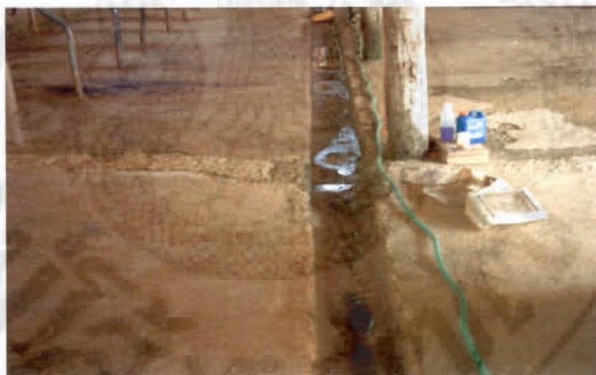
ภาพ 6 การสร้างรางระบายมูลและระบายน้ำ
