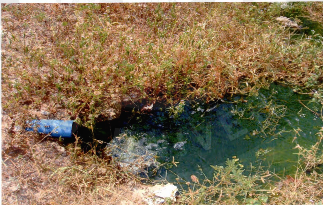
ภาพผนวก 10 การถ่ายน้ำขณะดำเนินการ
